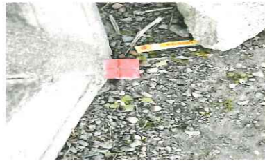
K4 既設プラスチック杭
