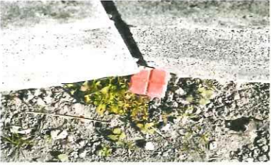
K6 既設プラスチック杭
