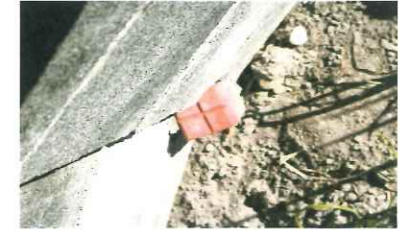
K10 既設プラスチック杭
