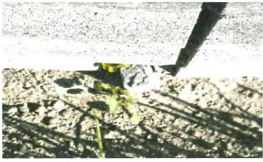
K7 既設プラスチック杭
